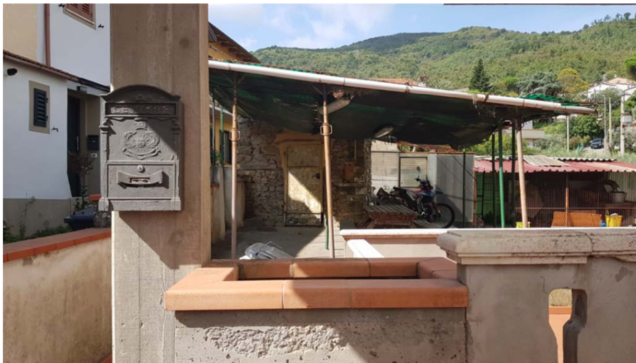
51. locale deposito e resede
