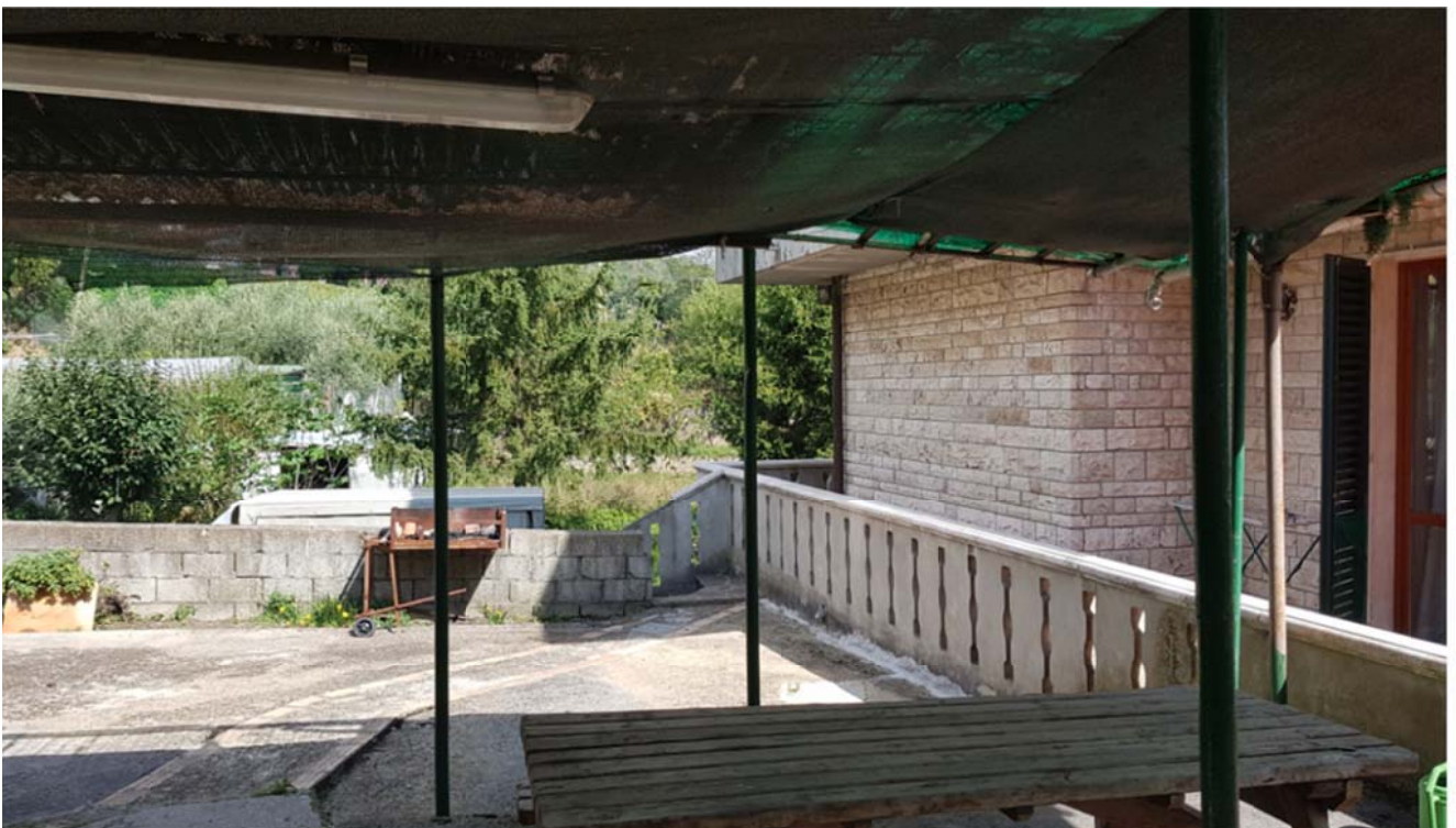
54. resede con tettoie da demolire
