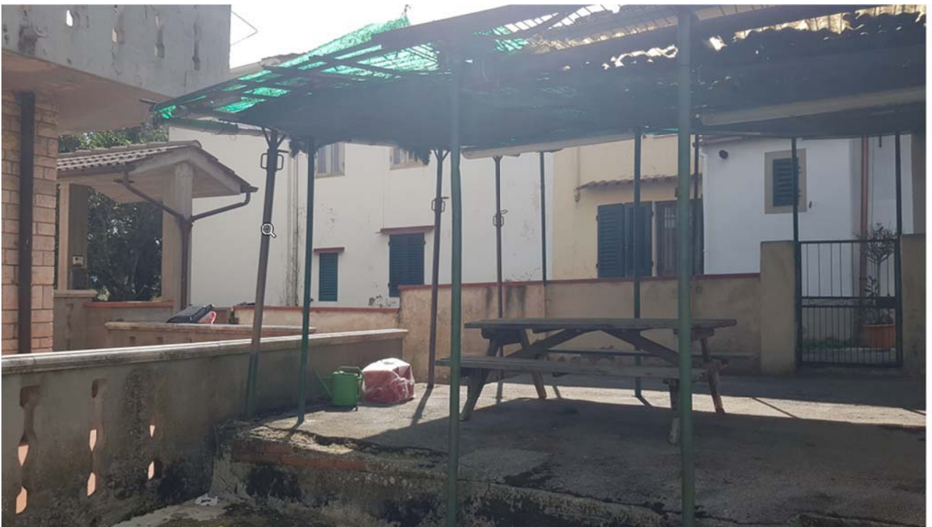
56. resede con tettoie da demolire
