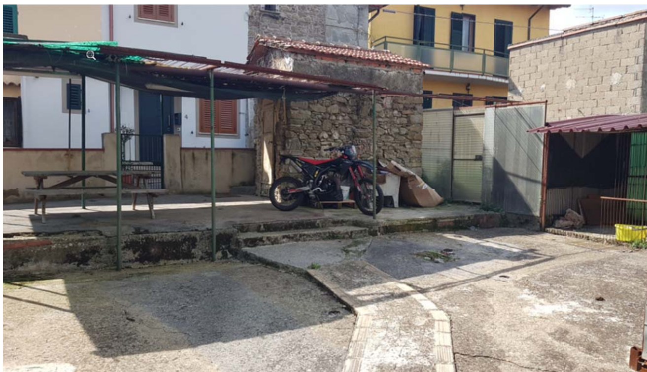
52. resede con tettoie da demolire
