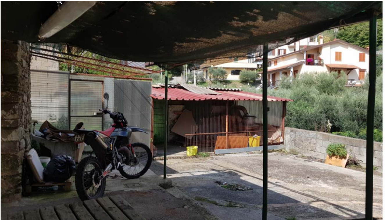
55. resede con tettoie da demolire
